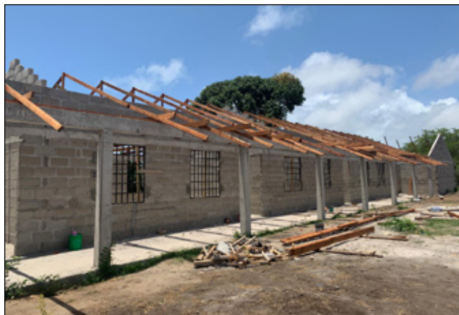
Obras de construcción del nuevo edificio escolar
